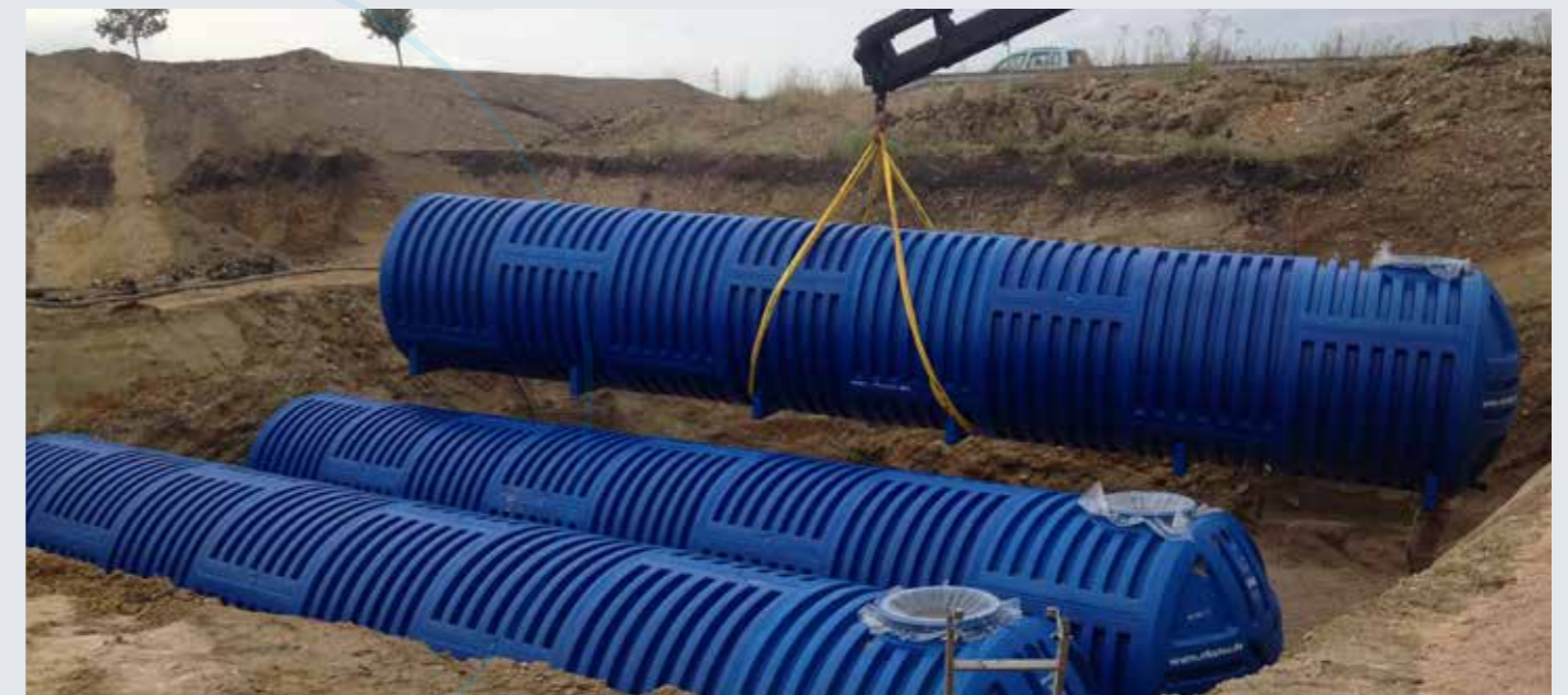
(Einbau Aqua'Terne 204-Batterie „Löschwassertank“)
